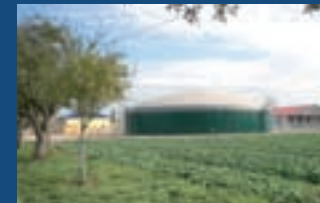
vorisolierte Wärmenetze von Biogasanlagen
